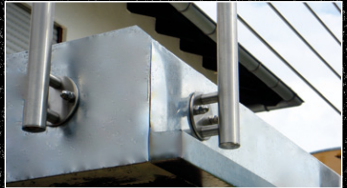
Tropfbleche und Rinnen zur Entwässerung
